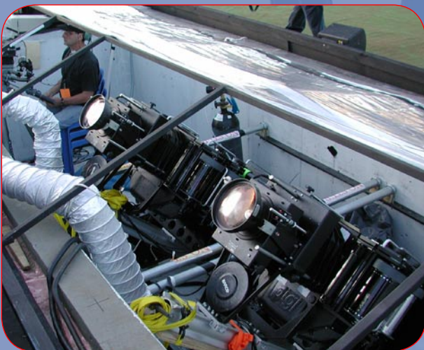
在舞台前的地面上开凿出混凝土结构的 投影坑
